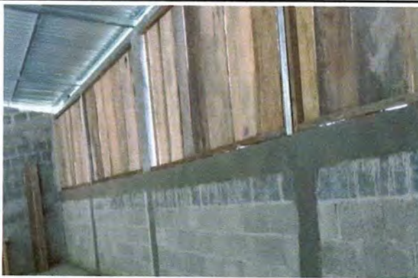
Foto 3: MEJORAMIENTO DE PAREDES
