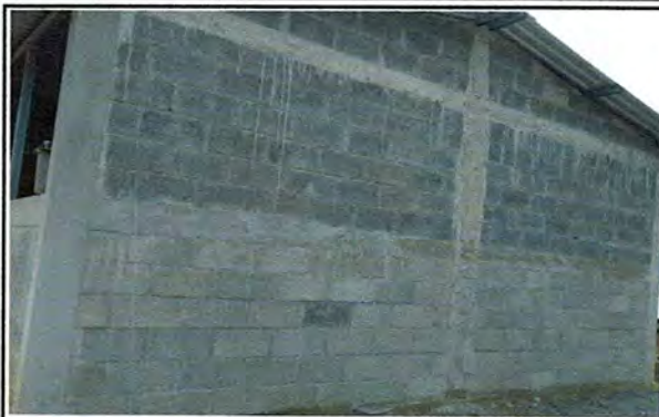
Foto 2: MEJORAMIENTO DE PAREDES
