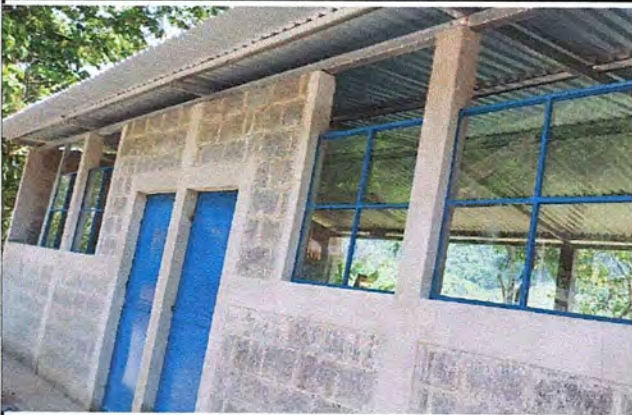
Foto 3: MEJORAMIENTO DE PUERTAS Y VENTANAS
