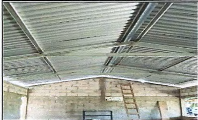
Foto 2: MEJORAMIENTO DE TECHO
