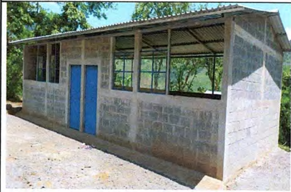
Foto 4: MEJORAMIENTO DE PAREDES
