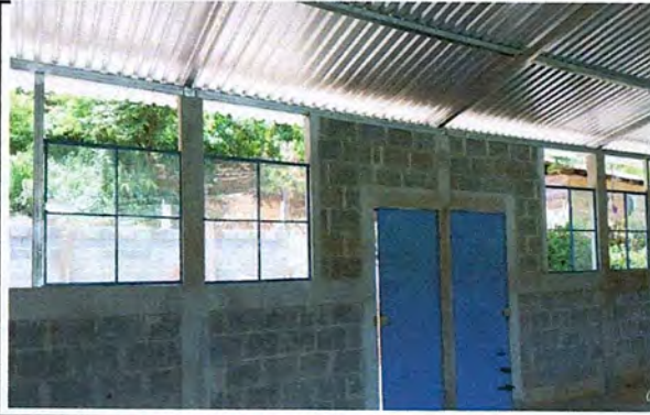
Foto 1: MEJORAMIENTO DE PAREDES
