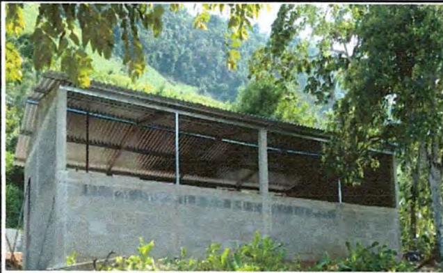
Foto 1: MEJORAMIENTO DE TECHO
