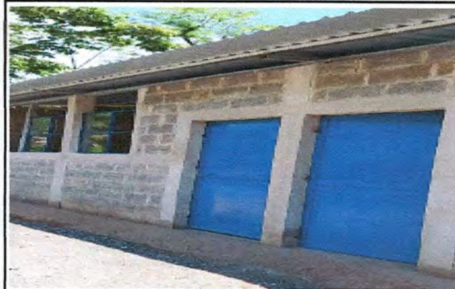
Foto 4: MEJORAMIENTO DE PUERTAS Y VENTANAS
